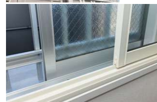
全住戸の内窓設置を実施
