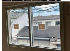
主居室の南側に内窓設置
